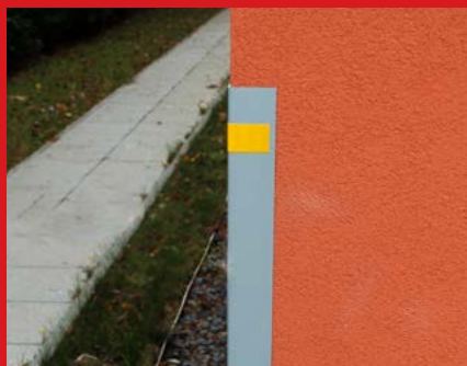
Slim PVC 65 na zateplené fasády
