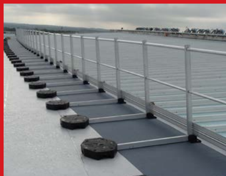
Střešní zábrany pro kolektivní ochranu
