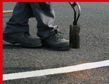
Termoplastické značení na asfalt a beton
