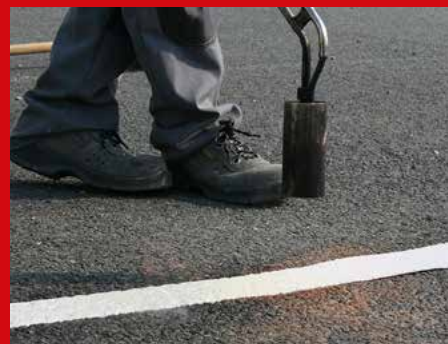
Termoplastické značení na asfalt a beton
