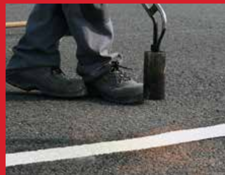
Termoplastické značení na asfalt a beton
